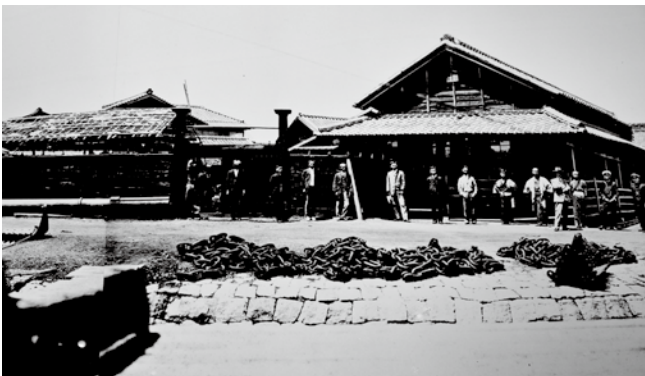
⑫若築建設所蔵 明治23~25年頃 旧本社写真(部分) →石垣のカーブ等の位置関係から見て、明治25年埋立範囲図と昭和4年「一般平面図(見取図)」の「X地点」付近から撮影か。 →第1期埋立工事の記念か。 →年代不詳であるが、若築建設史料群の中に、この写真に写る旧本社社屋と道路を描いた簡易図面が確認され、そこには本社と記されていることから、写真右側に写る長屋建物が旧本社社屋であろう。 →明治から昭和初期にかけて、社用地が分割されたことを示している。
