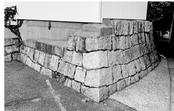
若築建設裏石垣の現況4 石垣K隅角部
