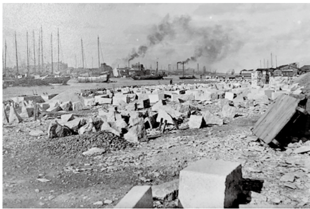
③「石材置場全景」 →奥側に搬入された未加工の切石があり、手前に加工された間知石が置かれている。陸揚げ場所で、順次加工していることが分かる。
