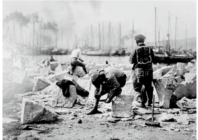
②「石材ノ加工」 現地での間知石作成風景を撮影したもの。 →切石状態で搬入された石材を、石工達が石垣構築現場で間知石を作成していることを示している。
