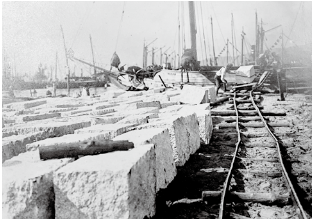
①「切石ノ陸揚」 →石垣の築石(間知石)となる石材が加工されていない状態で、現地に運び込まれることを示している。
