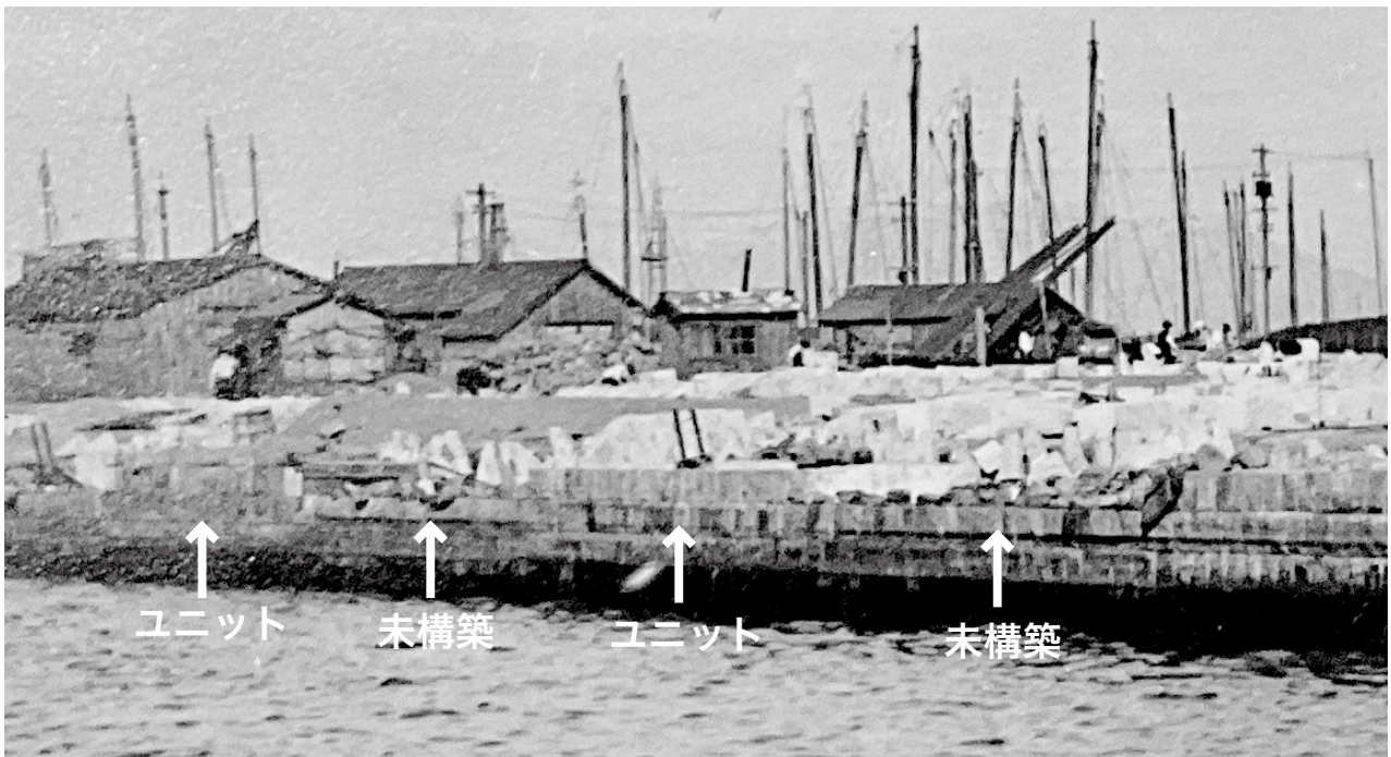
⑤「岸壁全面ヨリ見タル工事中ノ石垣」 →護岸石垣構築中に撮影されたもので、撮影時の最新構築状況を示している。これを見ると、最新の築石列が歯抜け状に積み重ねられており、まさに本稿で提示した「石垣構築のユニット」の状態を示している。
